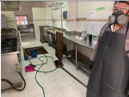
Limpieza trampa de grasas
