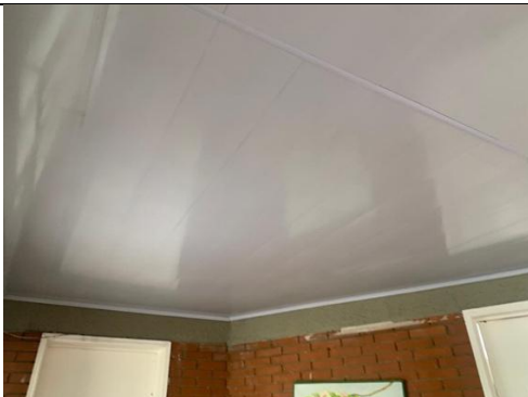
Instalación de techo PVC
